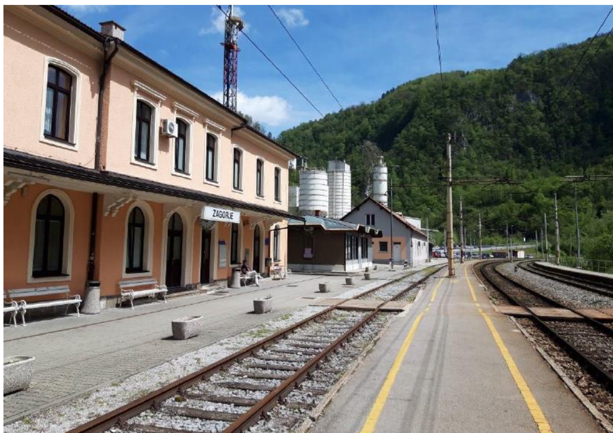
Slika 1: Železniška postaja Zagorje (obstoječe stanje)
