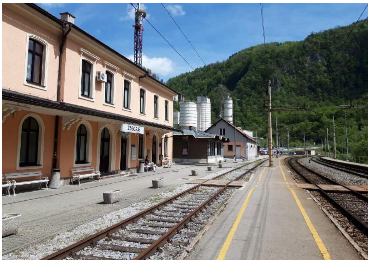
Slika 1: Železniška postaja Zagorje (obstoječe stanje)
