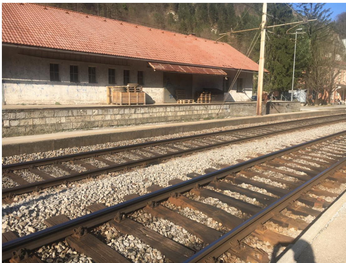
Slika 2: Skladišče in klančina ob tiru 1
